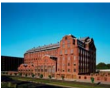
Ex "Molino el Porteño". El Porteño Building . Faena Hotel Ciudad de Buenos Aires. www.zonapuertomadero.com
