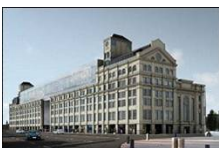
Ex "Molino El Progreso". Complejo Los Molinos Building . Ciudad de Buenos Aires. www.acceder.gov.ar
